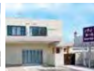
シティホール岸和田南館
