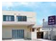
シティホール岸和田南館
