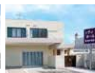
シティホール岸和田南館
