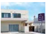
シティホール岸和田南館
