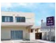
シティホール岸和田南館
