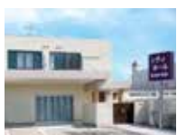
シティホール岸和田南館
