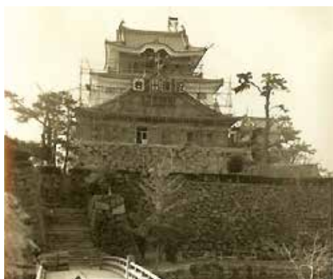
1954年の岸和田城天守閣再建工事の様子
